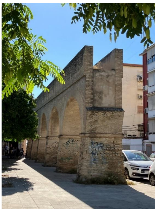
Ilustración 24: Detalle de arcadas levantadas en el siglo XIX de la reestructuración de los Caños de Carmona, a la altura del barrio de Los Pajaritos, en 2024, situadas en la acera izquierda de la Avenida de Málaga, en dirección al centro de la ciudad / JA COBEÑA
