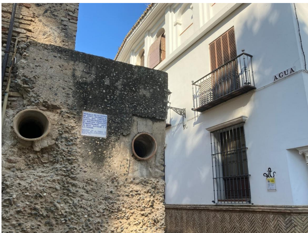
Ilustración 63: Detalle de las tuberías que conducían el agua desde los Caños de Carmona al Alcázar (izquierda) y a las fuentes y aljibes de la ciudad (derecha), situadas en la Torre del Agua, lindando con la calle del Agua, en el Barrio de Santa Cruz.
