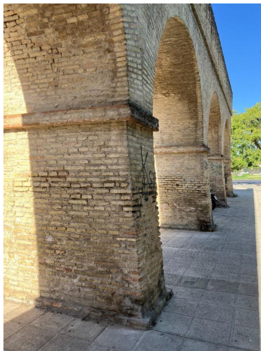
Ilustración 25: Detalle de arcadas levantadas en el siglo XIX de la reestructuración de los Caños de Carmona, a la altura del barrio de Los Pajaritos, en 2024, situadas en la acera izquierda de la Avenida de Málaga, en dirección al centro de la ciudad / JA COBENÑA
