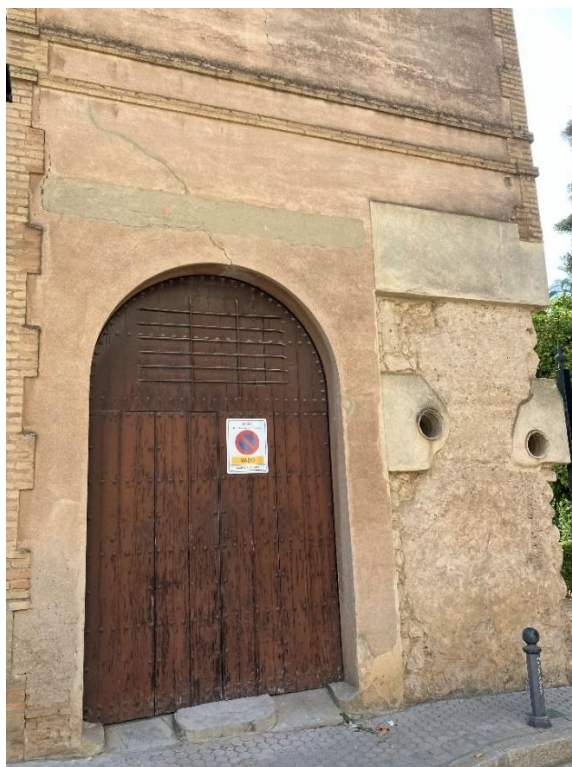
Ilustración 60: Detalle de las tuberías que conducían el agua desde los Caños de Carmona al Alcázar (izquierda) y a las fuentes y aljibes de la ciudad (derecha), situadas en la Torre del Agua, lindando con la actual calle del Agua, en el Barrio de Santa Cruz.
