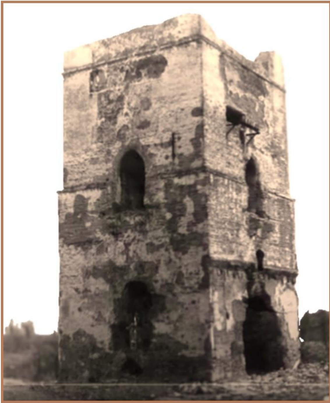
Ilustración 35: Imagen del Molino de Torreblanca, tratada fotográficamente, que sirve de modelo del llamado Molino del Pico, al haber sido construido sobre una torre almenara, posteriormente convertida en molino hidráulico de doble cubo.
