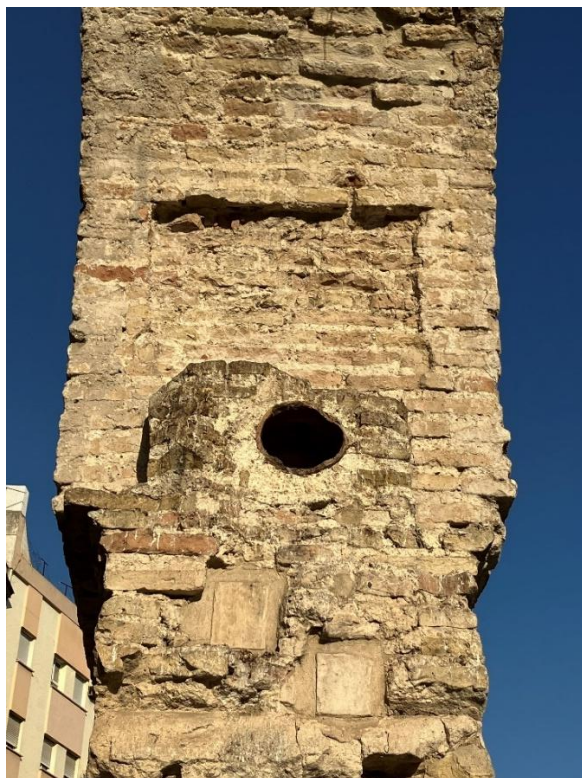
Ilustración 52: Detalle de tubería de hierro en las arcadas levantadas en el siglo XIX por la reestructuración de los Caños de Carmona, a la altura del comienzo de la calle Luis Montoto, en 2024, situadas en la acera izquierda en dirección a la Puerta de Carmona.
