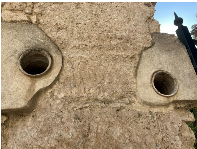
Ilustración 62: Detalle de las tuberías que conducían el agua desde los Caños de Carmona al Alcázar (izquierda) y a las fuentes y aljibes de la ciudad (derecha), situadas en la Torre del Agua, lindando con la calle del Agua, en el Barrio de Santa Cruz.
